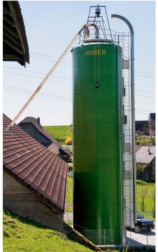
Absaugsystem aus zwei Silos. Mit einem Edelstahl-Abzweiger kann variabel aus den zwei Silos entnommen werden.
