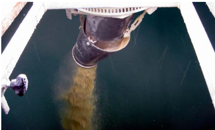
Bei kleineren Silos ohne Verlängerungsrohr.
