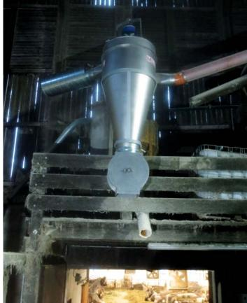
Das Turbo-Zyklon kann in der Scheune oder mit einer Einhausung am Dach mit Schalldämpfer montiert werden.
